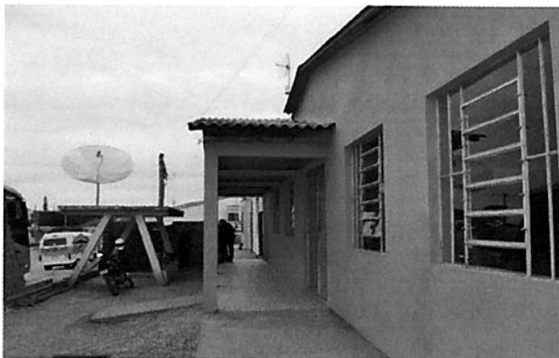
EEEM junto a EMEF Dr. Jaime Faria – Construção de muro de proteção para os estudantes junto a parada de ônibus via autonomia financeira.
