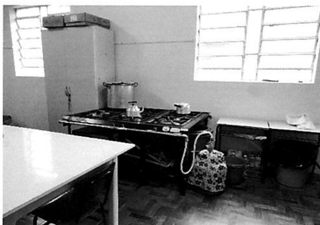
Escola Estadual de Ensino Médio João Isidoro Lorentz – Botijão de gás acondicionado próximo do fogão e de produtos de limpeza.
