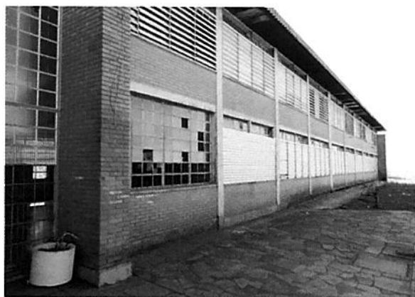
Fachada Externa da Escola, com perfis de alumínio destinados a proteção dos vidros.
